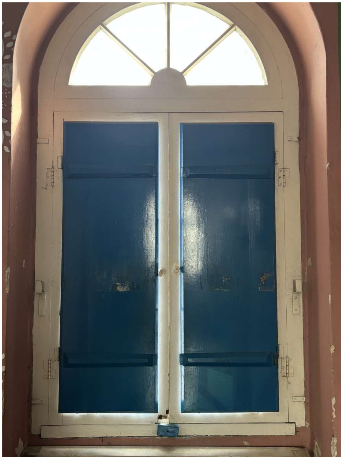
Figura 60: Desgaste da pintura do madeiramento da esquadria. Fonte: Prosul.
