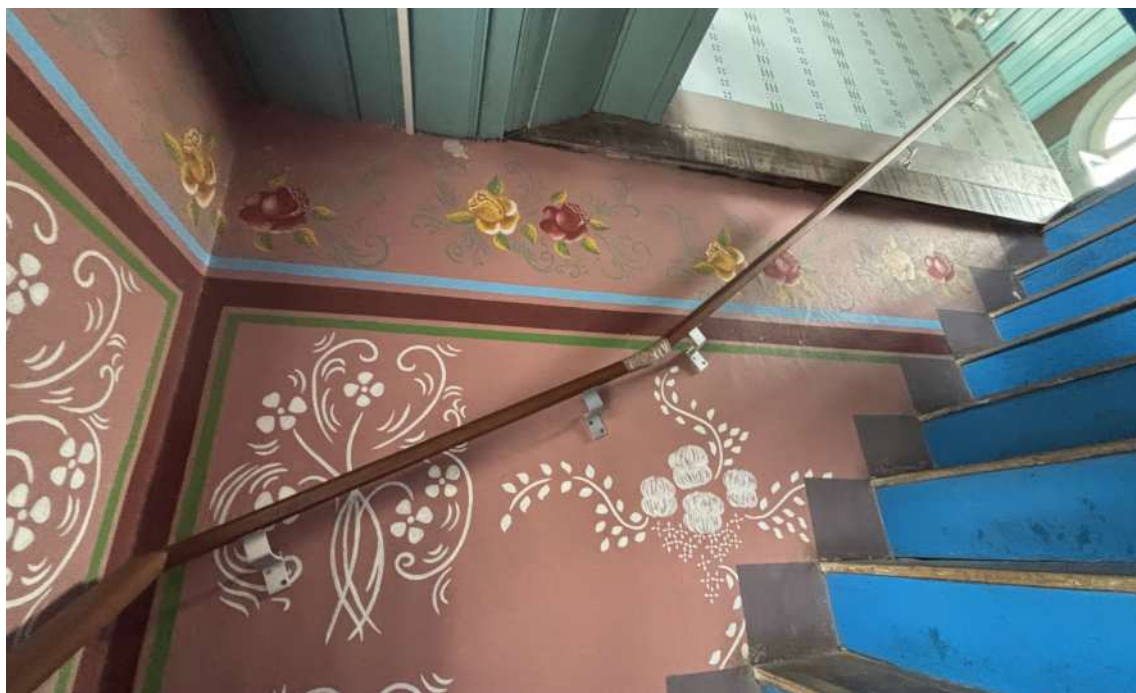
Figura 70: Corrimão de madeira com peças quebradas e desgaste na pintura da escada. Fonte: Prosul.
