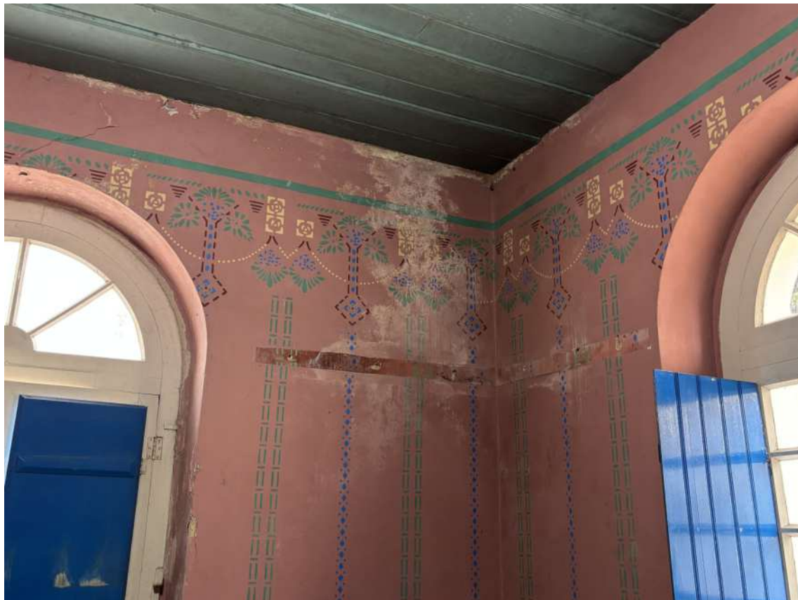
Figura 69: Eflorescência e bolor na alvenaria e pintura mural. Fonte: Prosul.
