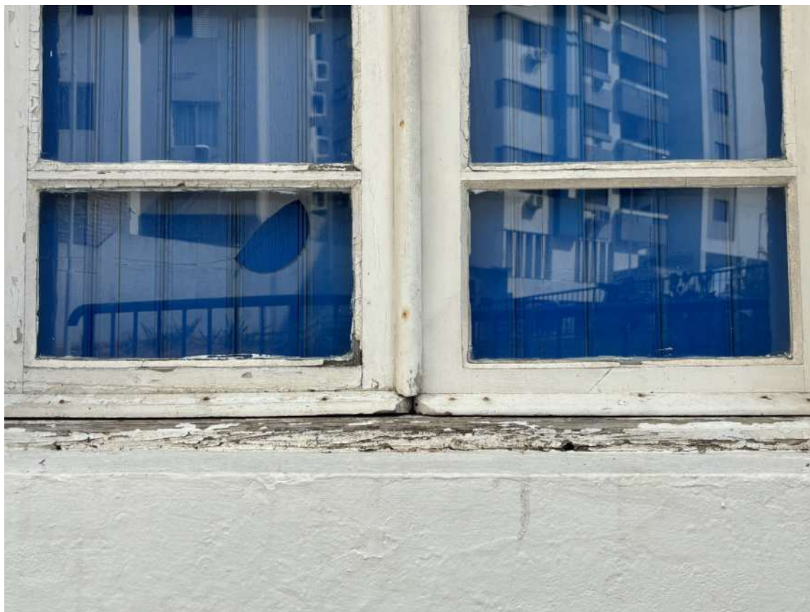
Figura 58: Vidro quebrado e degradação do madeiramento da esquadria. Fonte: Prosul.
