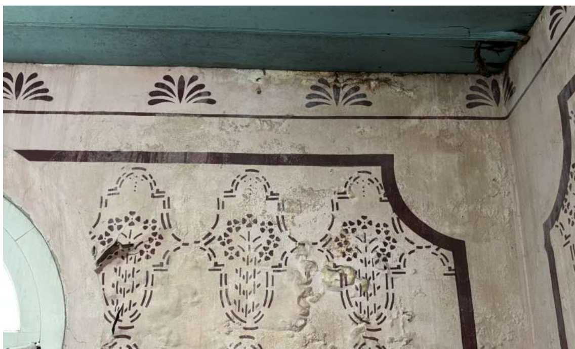
Figura 77: Degradação do forro de madeira e umidade ascendente. Fonte: Prosul.
