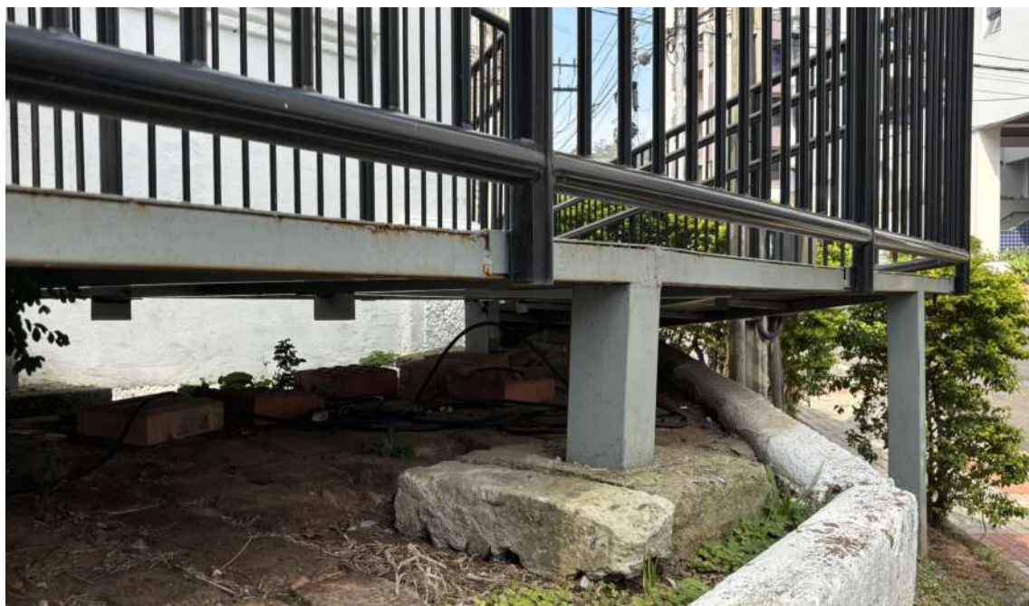
Figura 65: Rampa metálica de acesso ao museu com ferrugem. Foto: Prosul
