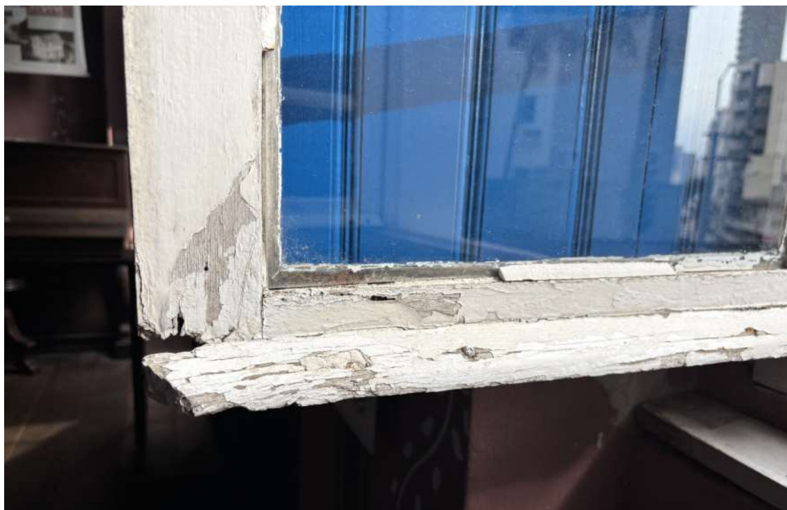
Figura 59: Degradação do madeiramento da esquadria. Fonte: Prosul.
