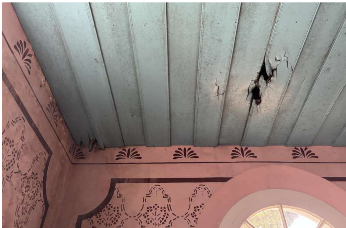
Figura 76: Degradação do forro de madeira e umidade ascendente. Fonte: Prosul.
