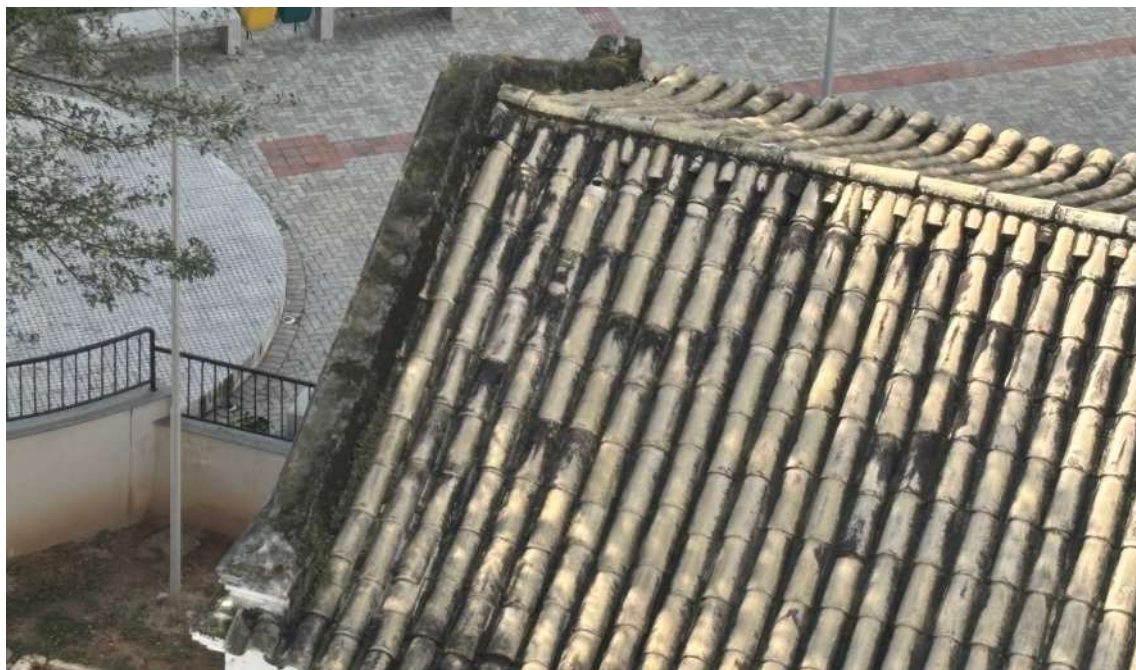
Figura 62: Vegetação e sujidade na cobertura. Fonte: Prosul.
