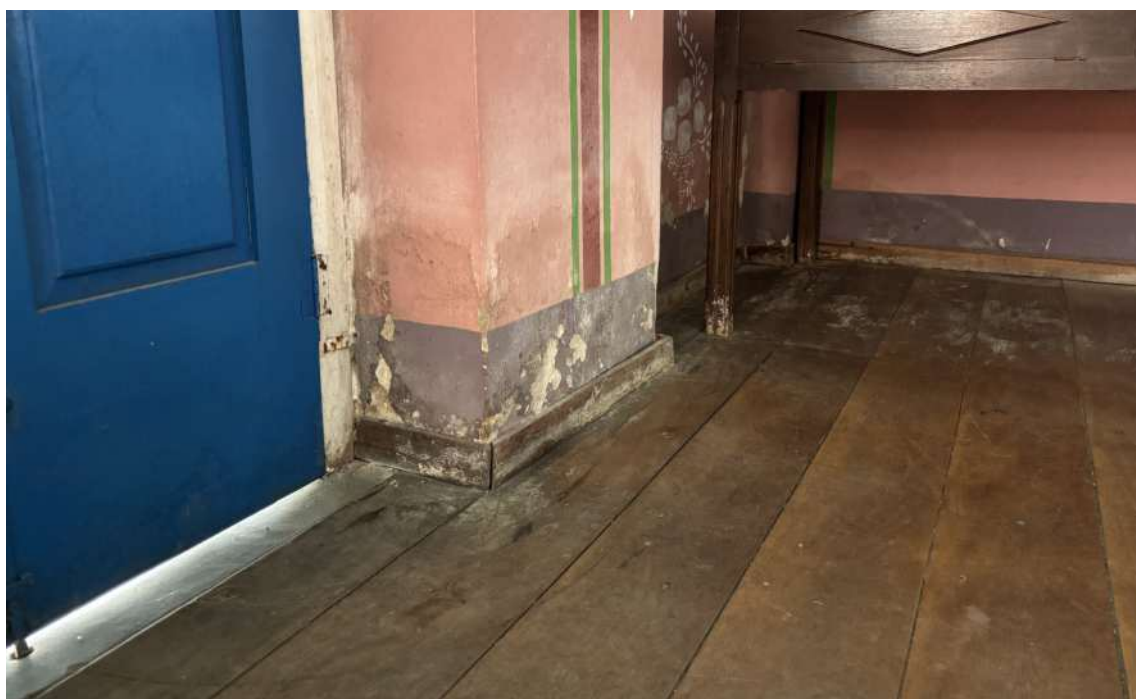
Figura 68: Degradação da alvenaria e rodapés. Fonte: Prosul.
