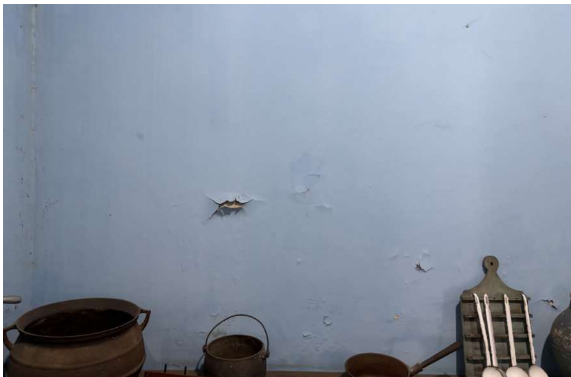
Figura 74: Desplacamento da tinta. Fonte: Prosul.
