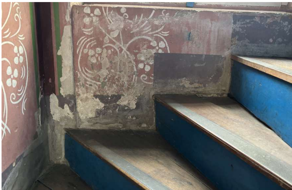
Figura 72: Descascamento da pintura mural e degradação do reboco. Fonte: Prosul.
