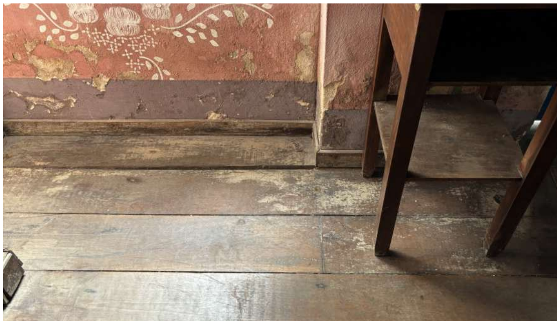
Figura 67: Degradação e sujidade no piso e rodapé de madeira. Fonte Prosul
