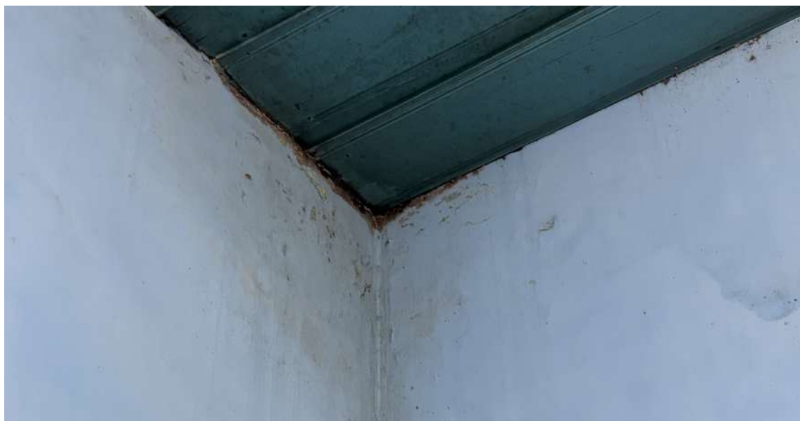
Figura 73: Infiltrações e umidade descendente. Fonte: Prosul.
