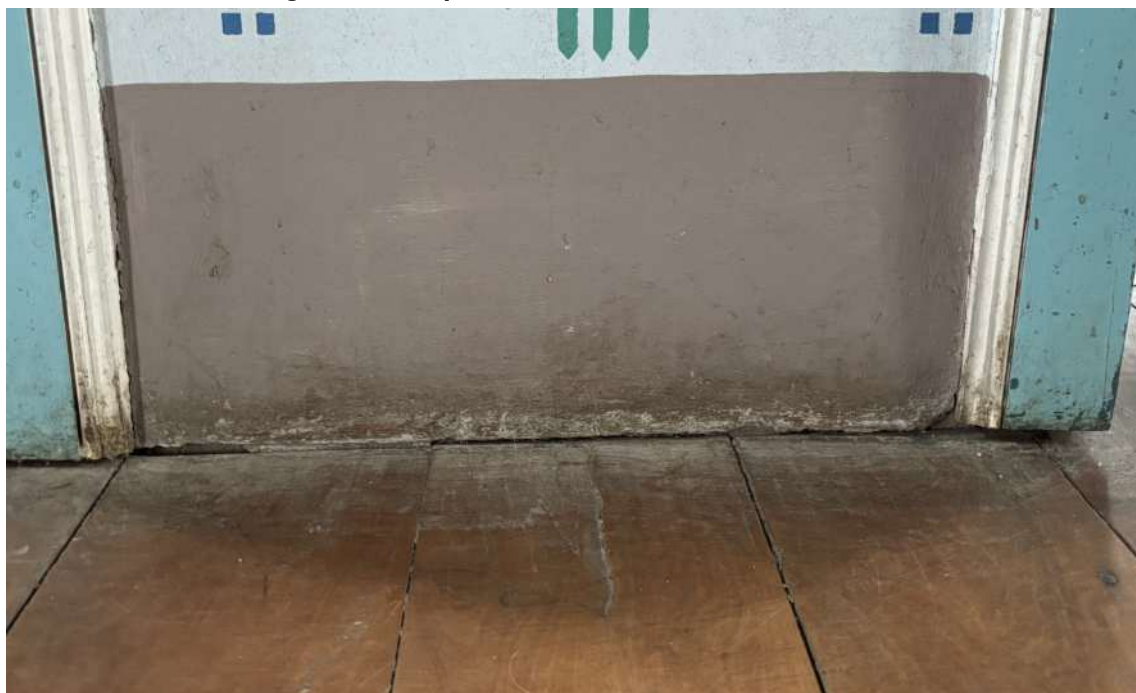
Figura 75: Ausência de rodapés e degradação do reboco. Fonte: Prosul.
