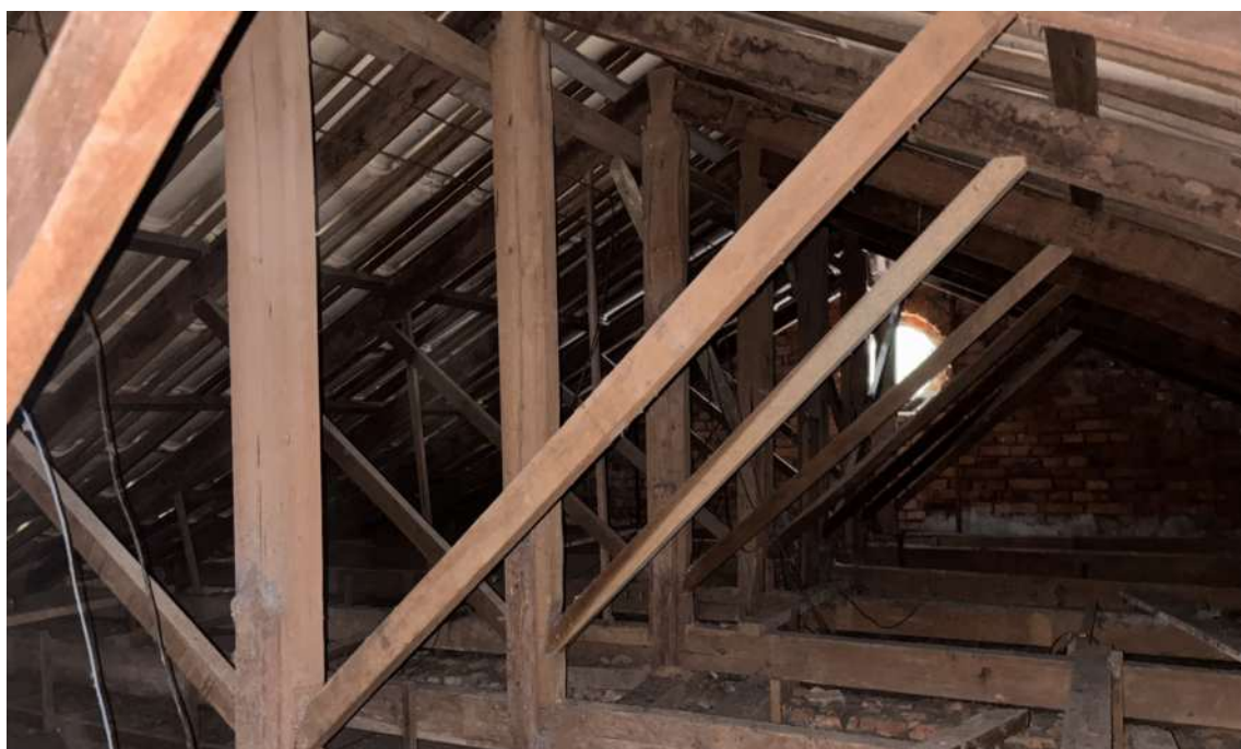
Figura 79: Sujidade na cobertura e ações de xilófagos em alguns madeiramentos. Fonte: Prosul.
