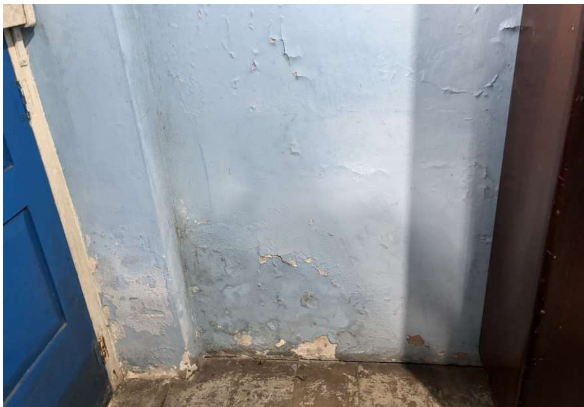
Figura 71: Degradação do reboco e umidade ascendente. Fonte: Prosul.
