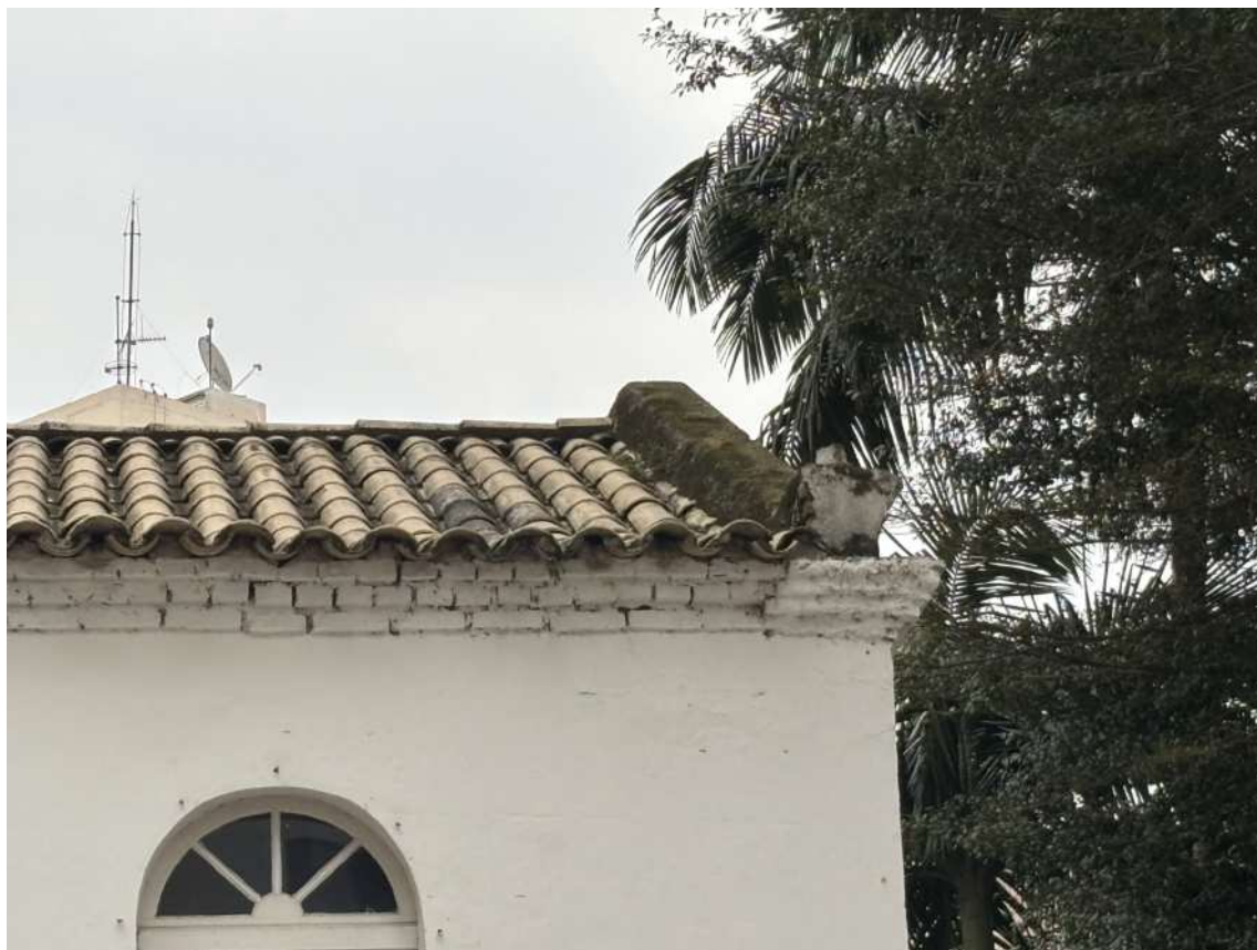
Figura 54: Cimalha com ação de desagregação e perda do material e Vegetação de pequeno porte na cobertura do Museu Augusto Casagrande. Fonte: Prosul.
