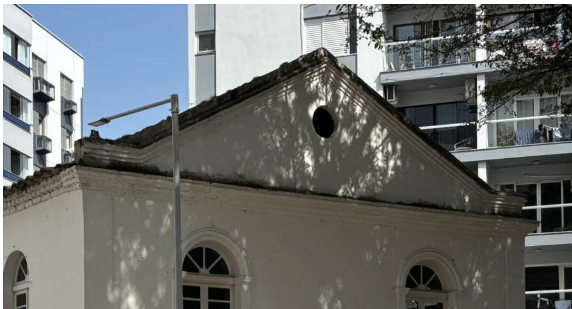
Figura 55: Cimalha com ação de desagregação e perda do material e Fonte: Prosul.
