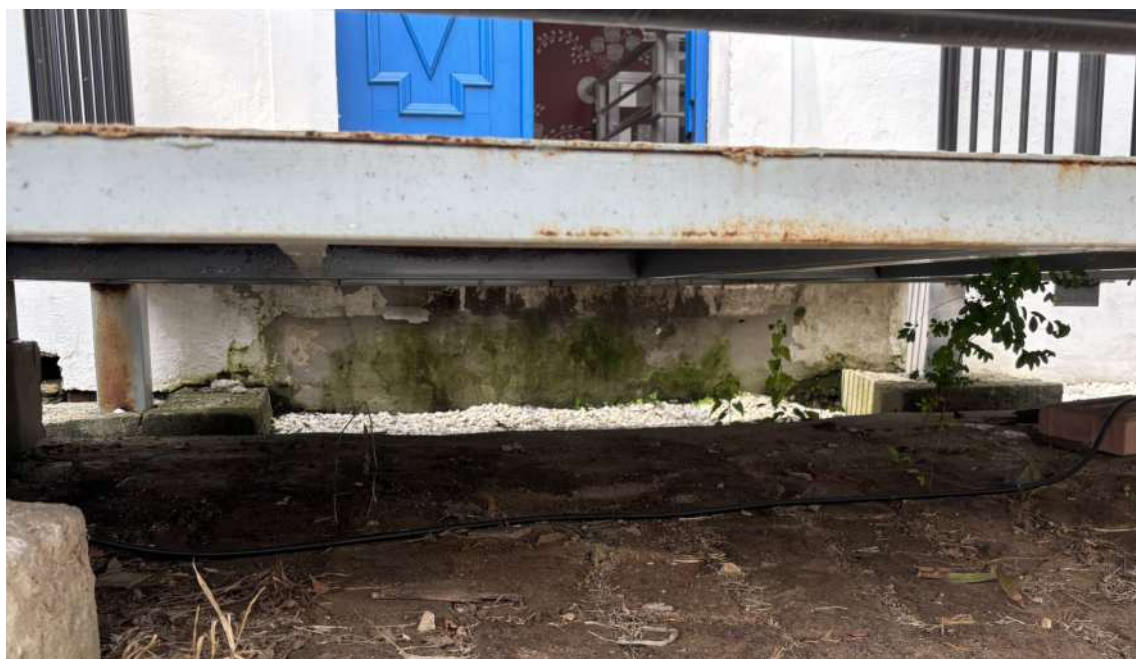
Figura 66: Ferrugem na estrutura da rampa de acesso do Museu Augusto Casagrande. Fonte: Prosul
