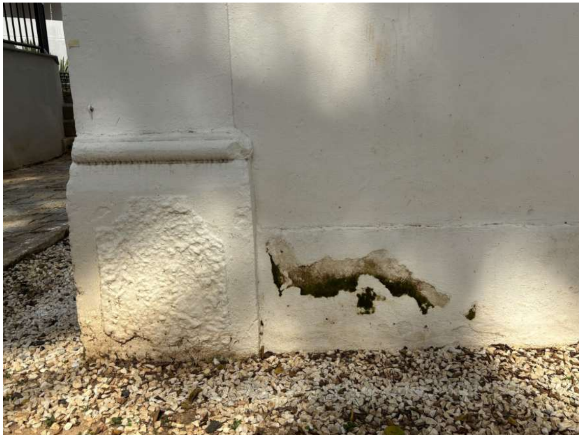
Figura 57: Umidade ascendente no embasamento da edificação. Fonte: Prosul.
