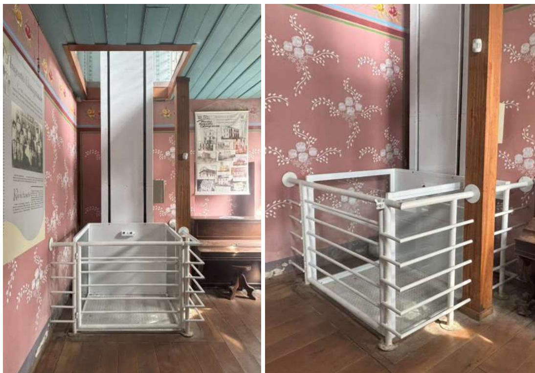
Figura 47: Elevador metálico, Museu Augusto Casagrande. Fonte: Prosul
