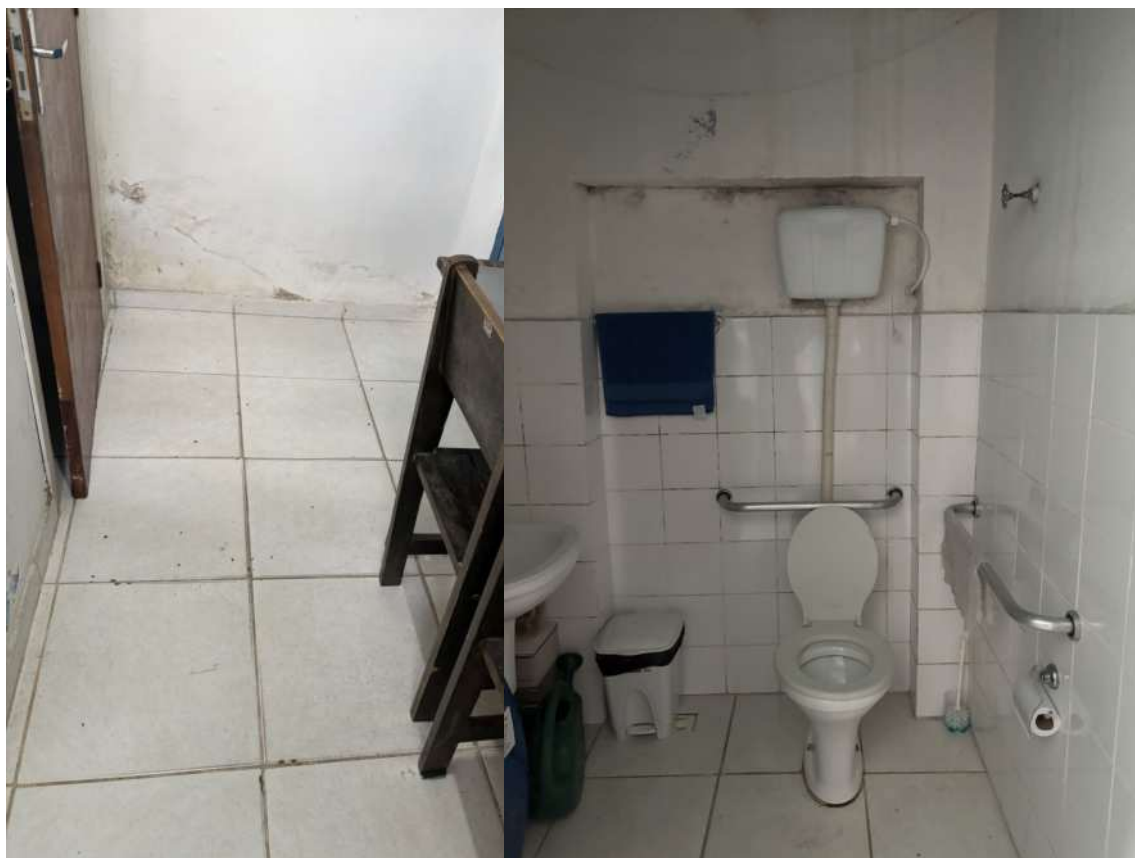
Figura 39: Piso cerâmico 45x45 nos espaços da Copa e banheiro, Museu Augusto Casagrande. Fonte: Prosul
