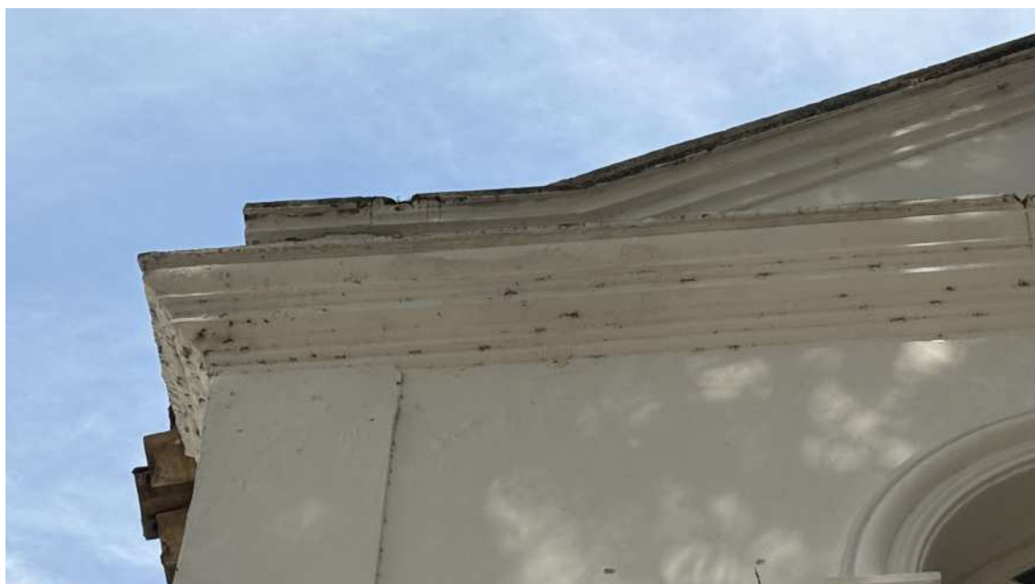
Figura 56: Cimalha com ação de desagregação e perda do Fonte: Prosul.
